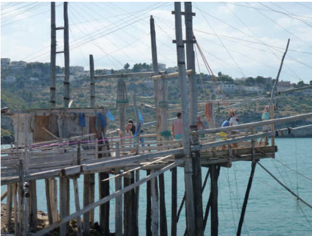
Il ponte del trabucco con l'argano per issare la rete.
