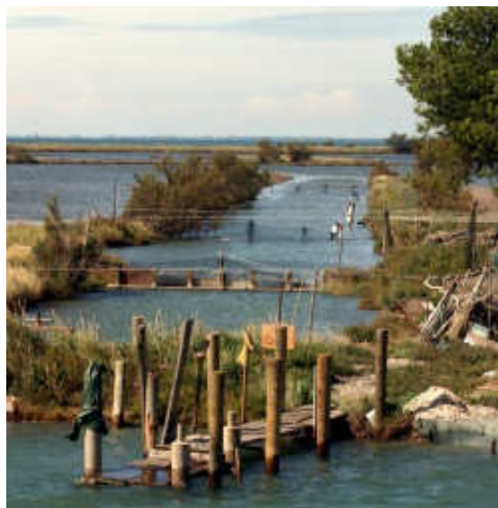
Canali per incanalare i pesci.
