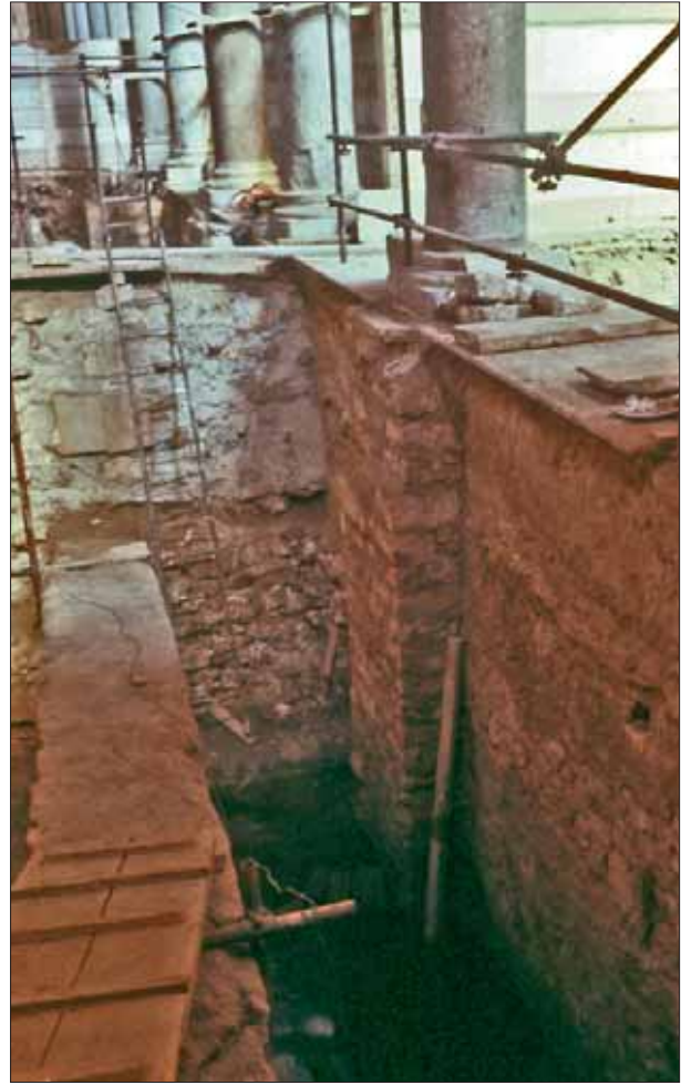
Fig. 4. - Muro di catena del colonnato rinvenuto durante gli interventi degli anni '70 (f. P.B.D.).
