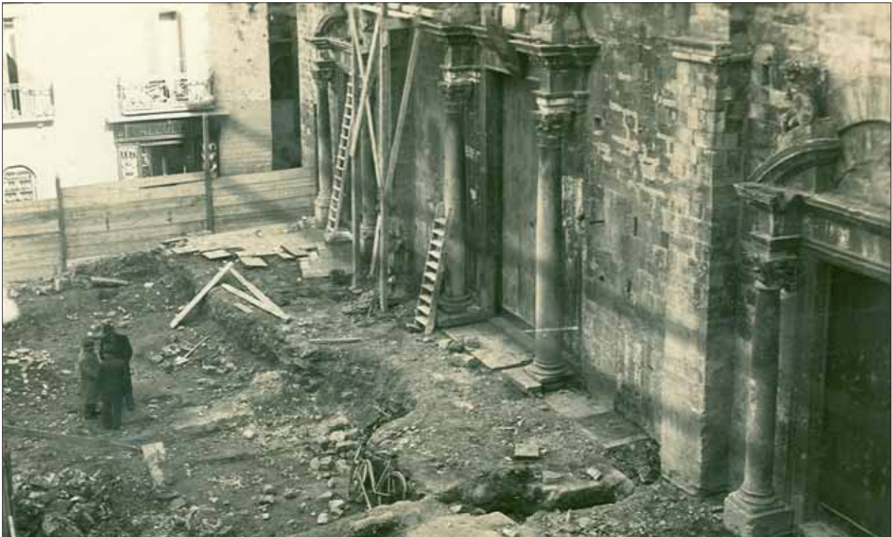
Fig. 15. - Rinvenimenti di opere in muratura nell'atrio davanti alla facciata della chiesa sotto la scalinata settecentesca (foto AFS).
