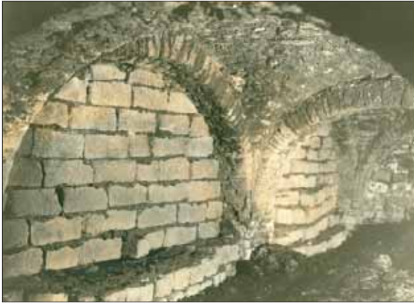
Fig. 14. - Ambiente 2: muro per la sepoltura dei canonici (foto AFS).
