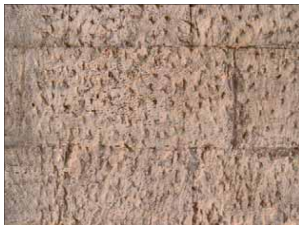
Fig. 4. - Chiesa superiore: muratura tipo A fase 2 (f. dell'A.).
