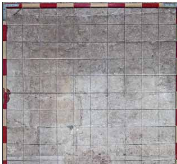
Fig. 1. - Chiesa superiore: muratura tipo A (f. dell'A.).
