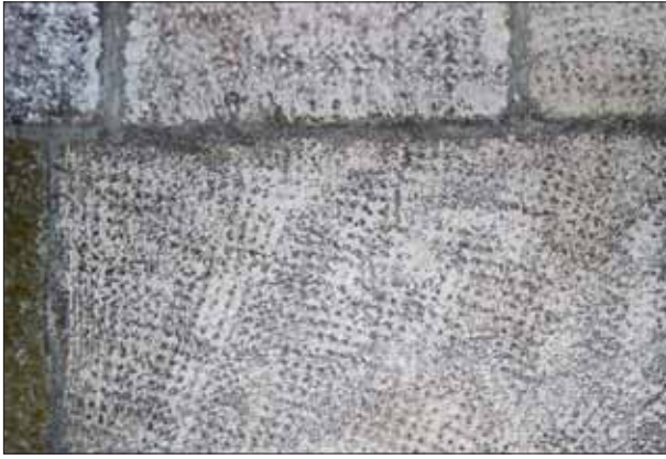
Fig. 9. - Chiesa superiore: muratura con scialbi di cemento e trattamento a bocciarda (f. dell'A.).
