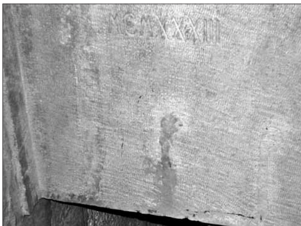
Fig. 7. - Chiesa superiore: muratura tipo C con iscrizione lavori anni '30 (f. dell'A.).
